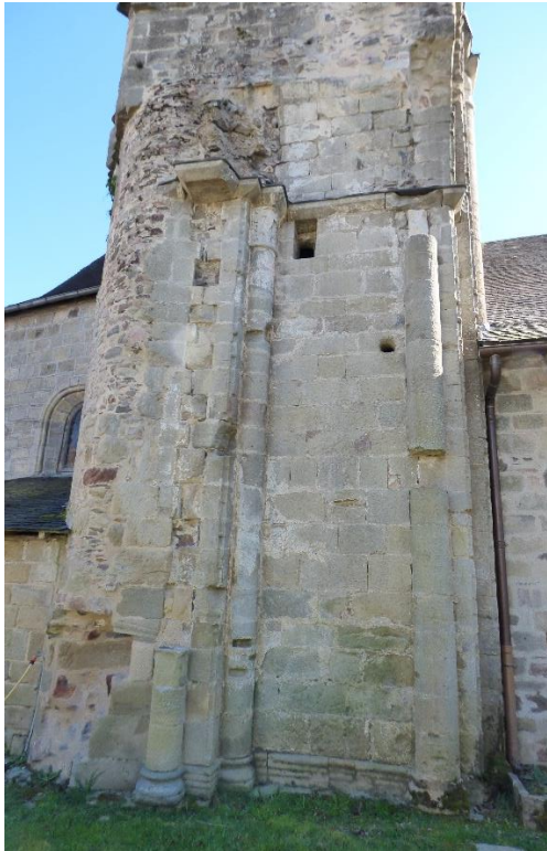
Vestiges sur façade Nord
